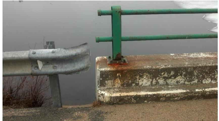
Non Conforming Guardrail
